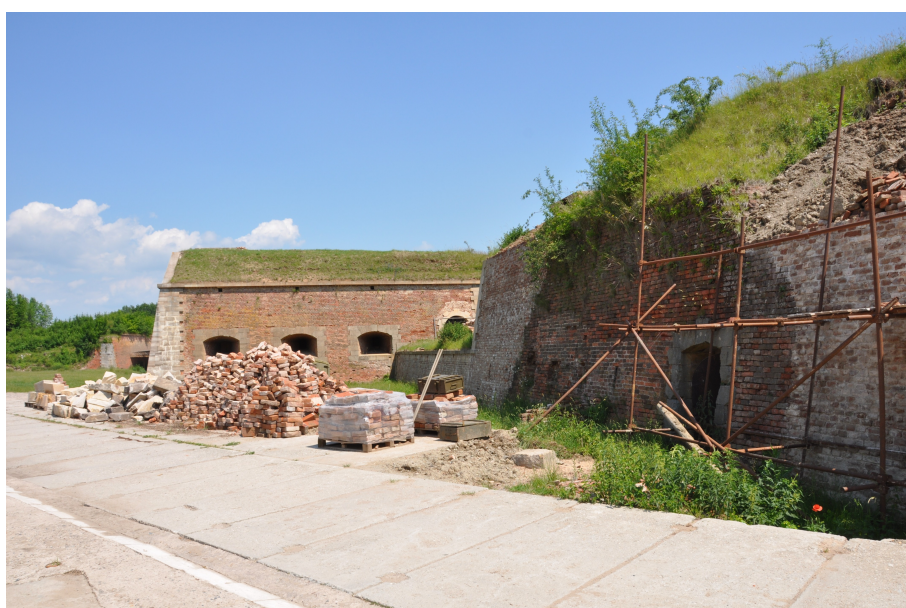
Červen 2011, pohled od rekonstruovaného pravého nároží Ravelinu XIV k pravému boku reduitu a zrekonstruované střelecké galerii, spojující oba prvky. Zdroj: archiv autora.
