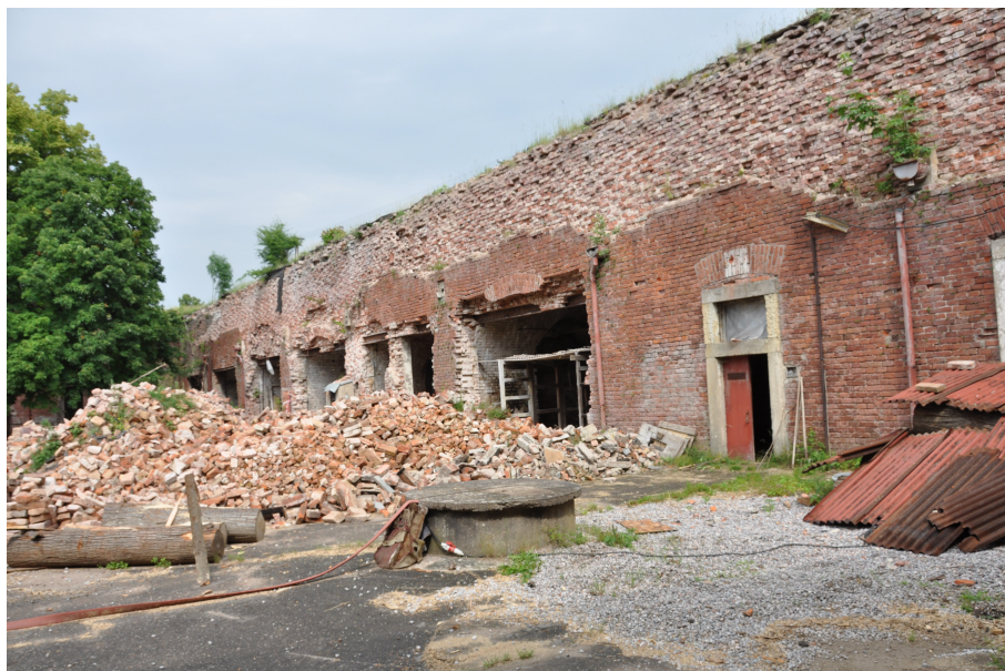
Červen 2011, pohled na vnitřní kasematy pravého boku Bastionu IV a částečně zdemolované cihlové opláštění, které prochází rekonstrukcí. Zdroj: archiv autora.
