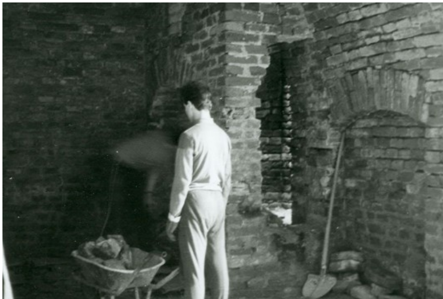
Květen 1991, opravy vnitřního prostoru strážnice v Retranchmentu XVIII. Zdroj: „Společnost Retranchment No. XVIII“, navštíveno 1. 6. 2011, http://pevnost.josefov.sweb.b.cz/ .
