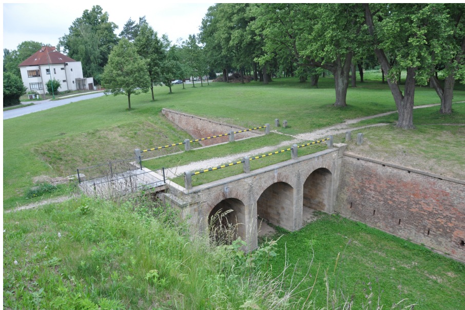
Červen 2011, pohled na obnovený pevnostní most do Ravelinu XVII, který se nalézá v příkopu podél jeho pravé líce. Most byl ochránci pevnosti vykopán a obnoven v letech 1998-1999. Zdroj: archiv autora.
