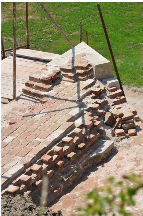
Červen 2011, postup prací na rekonstrukci pravého nároží Ravelinu XIV a shromážděný stavební materiál, cihly a kameny připravené pro dozdivání armování špičky nároží. Zdroj: archiv autora.
