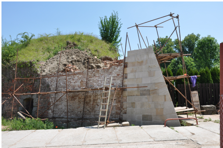
Červen 2011, postup prací na rekonstrukci pravého nároží Ravelinu XIV. Je zřetelně vidět rozsah původní destrukce a nového zdiva. Zdroj: archiv autora.
