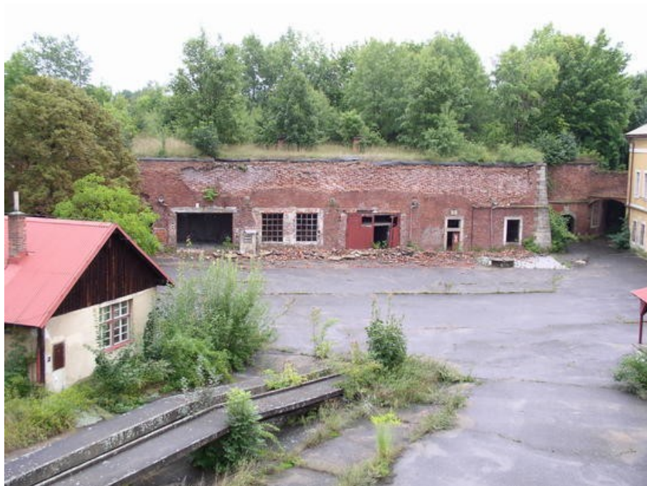
Vnitřní prostor Bastionu IV během předávání od Armády ČR. Zdroj: www.bastion4.cz
