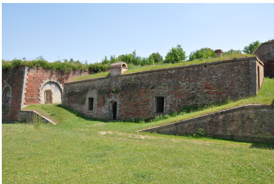
Červen 2011, pohled na šíjovou část, zrekonstruovaná strážnice a prachárny. Zdroj: archiv autora.
