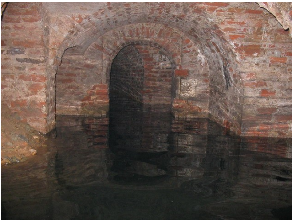
Josefov – nahore : korunní hradba u Ravelinu XXXVIII. V takovém stavu se nachází poměrně rozsáhlé pasáže josefovského podzemí a protiminových galerií. Pasáž u výpadové branky do příkopu je zatopená, vlevo vidíme zával do spojovací chodby v envelopě. Dole: stav envelopy, zanesené odpady. „Ravelin XIV“, navštíveno 1. 6. 2011, http://www.josefov.com . Koncepční záchrana narušeného josefovského podzemního systému zatím nebyla zahájena.
