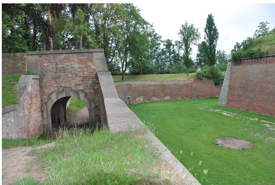
Červen 2011, pravý klenutý průchod a traverza na Shromaždiště XXX, druhé místo na povrchu pevnostního systému, kde pokračovaly záchranné a rekonstrukční práce po dokončení levého průchodu. Vpravo levý líc Bastionu I, hlavní příkop a viditelná hlavní galerie v kontreskarpě se vstupem. Zdroj: archiv autora.
