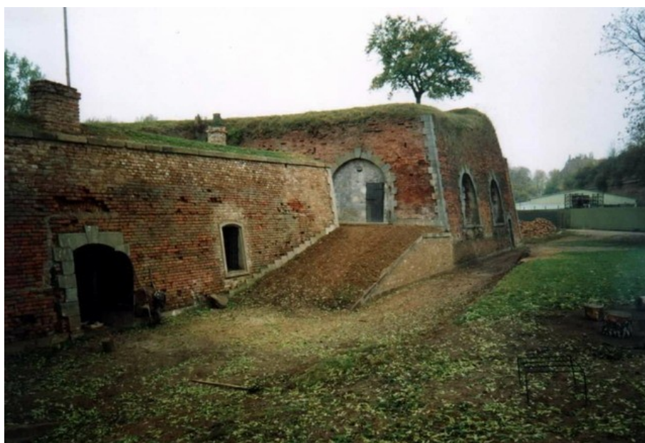
Rok 2000, kompletně opravená pravá prachárna a pravý nájezd do reduitu. „Ravelin No. XIV – pevnost Josefov“, navštíveno 1. 6. 2011, http://www.josefov.com .
