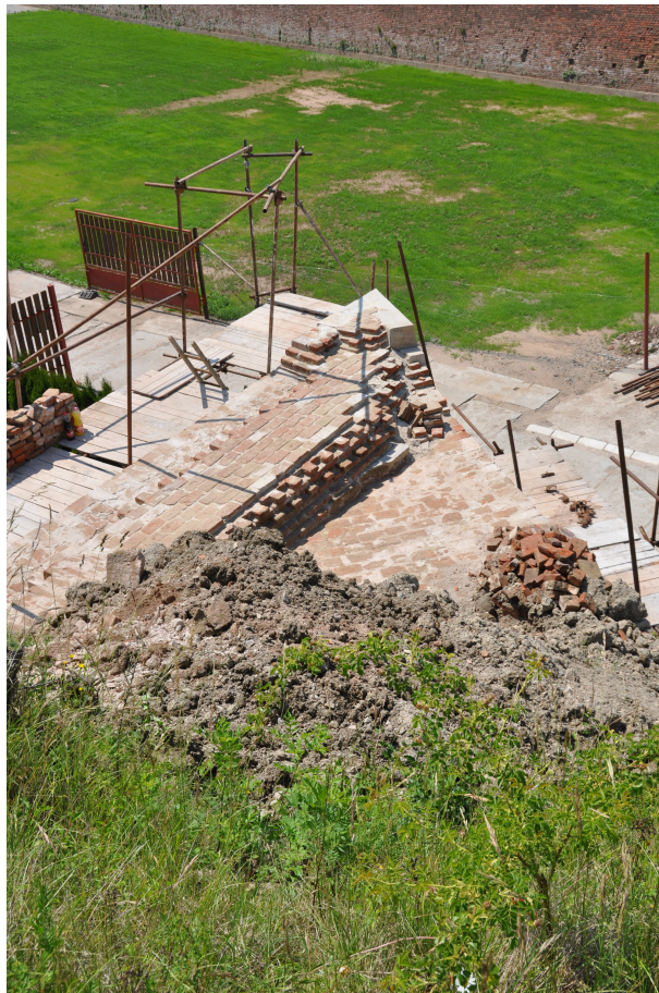
Červen 2011, postup prací na rekonstrukci pravého nároží Ravelinu XIV a shromážděný stavební materiál, cihly a kameny připravené pro dozdivání armování špičky nároží. Zdroj: archiv autora.
