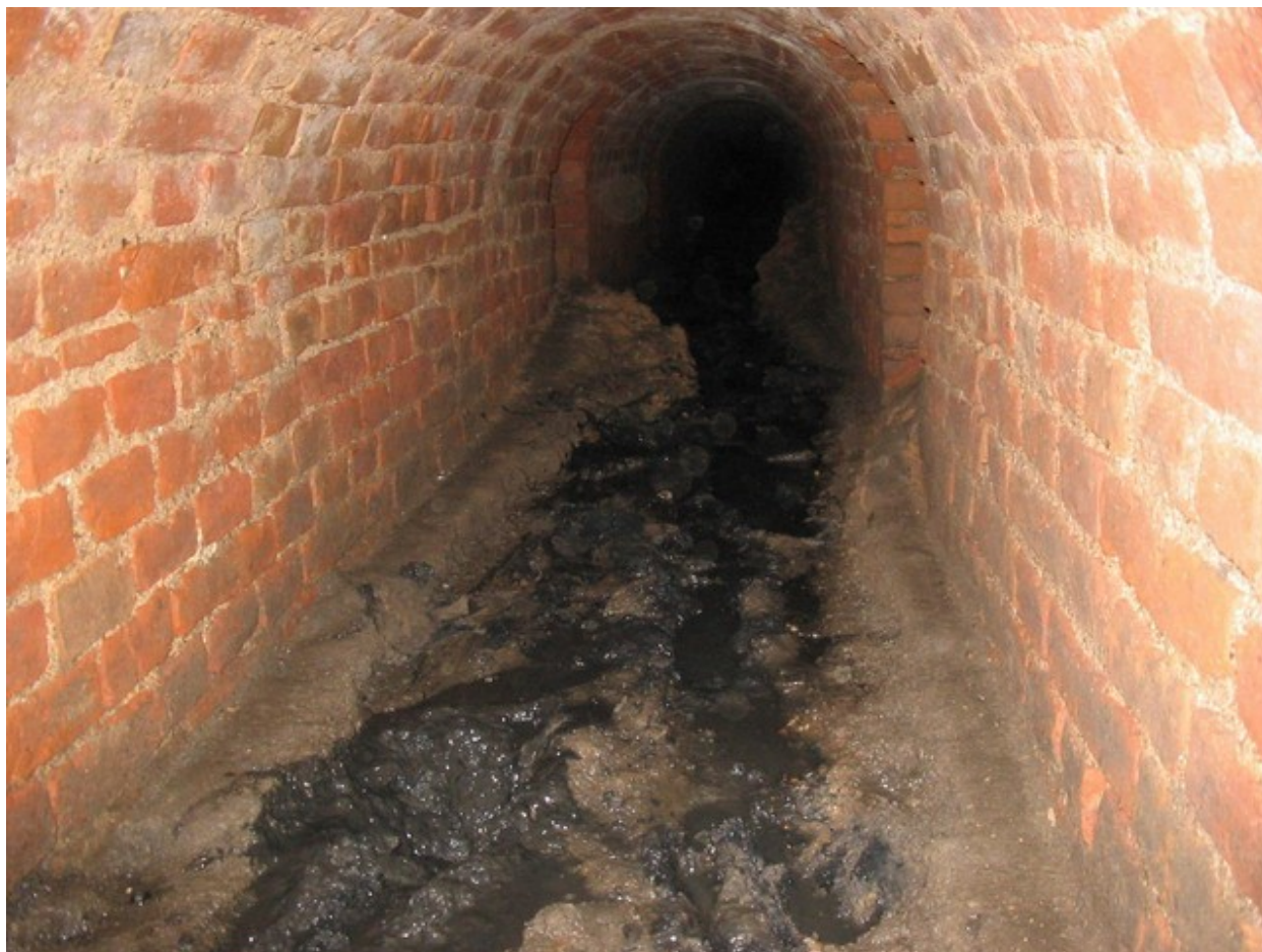
Josefov – nahore : korunní hradba u Ravelinu XXXVIII. V takovém stavu se nachází poměrně rozsáhlé pasáže josefovského podzemí a protiminových galerií. Pasáž u výpadové branky do příkopu je zatopená, vlevo vidíme zával do spojovací chodby v envelopě. Dole: stav envelopy, zanesené odpady. „Ravelin XIV“, navštíveno 1. 6. 2011, http://www.josefov.com . Koncepční záchrana narušeného josefovského podzemního systému zatím nebyla zahájena.
