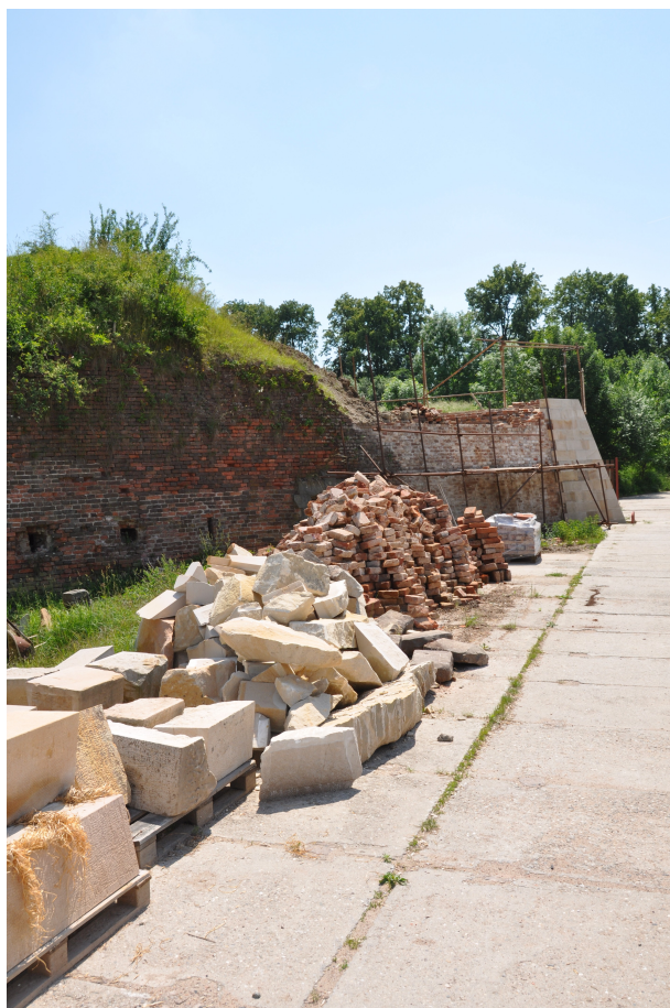
Červen 2011, postup prací na rekonstrukci pravého nároží Ravelinu XIV a shromážděný stavební materiál, cihly a kameny připravené pro dozdivání armování špičky nároží. Zdroj: archiv autora.
