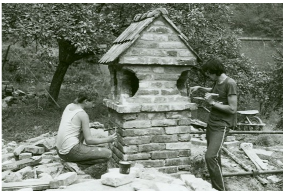
Červen 1991, zdění komínu strážnice na Retranchmentu XVIII. Vlevo Milan Libich, vpravo Miroslav Vašata. Zdroj: „Společnost Retranchment No. XVIII“, navštíveno 1. 6. 2011, http://pevnost.josefov.sweb.cz/ .
