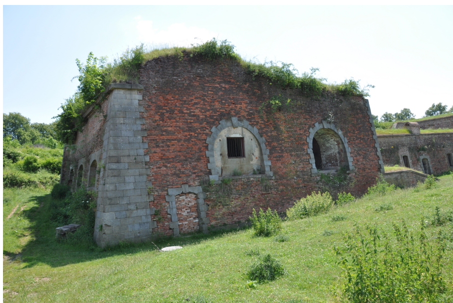
Červen 2011, levá pasáž (bok a nároží) reduitu Ravelinu XIV, kde zatím neproběhly úplné rekonstrukční a záchranné práce. Zdroj: archiv autora.
